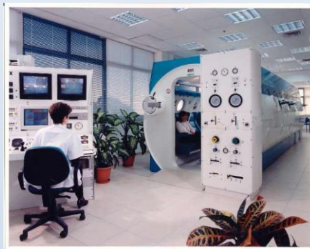
איור 15: חדר תא לחץ
