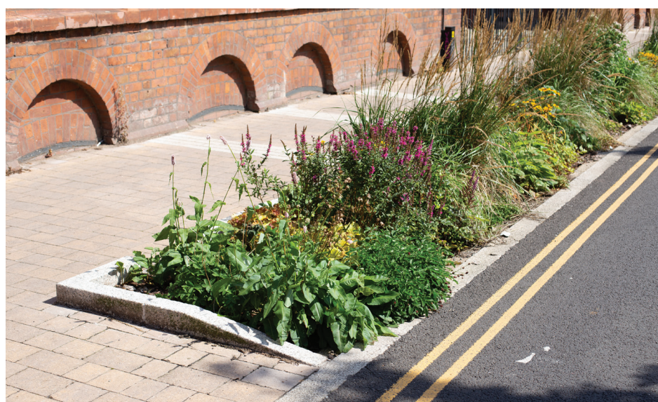
תשתית מחלחלת בשולי כבישים ומדרכות על ידי הקמת גינות וחיפוי משהה ומחלחל
